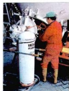
Heiße Luft: Mit einem Gasbrenner wird das Silo getrocknet.
